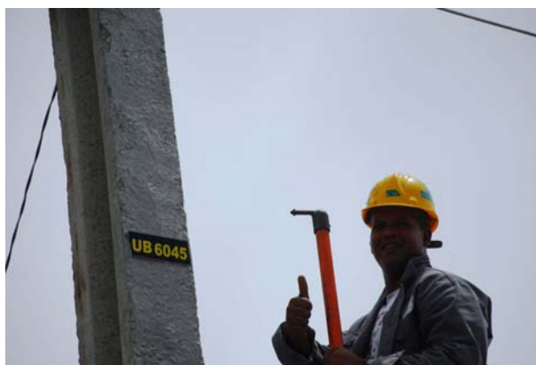
CRUCIAL MOMENTO EN QUE EL TRABAJADOR DE LA EMPRESA ELECTRICA CONECTA LA ELECTRICIDAD A LA COMUNIDAD DE JOVA
