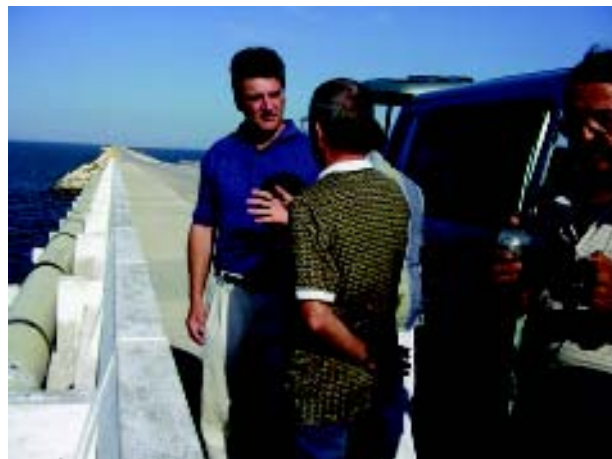
Fig. 11.1. Uno de los numerosos puentes que favorecen la circulación del agua a través del pedraplén Caibarién-Santa María (Foto: Allen Putney).
