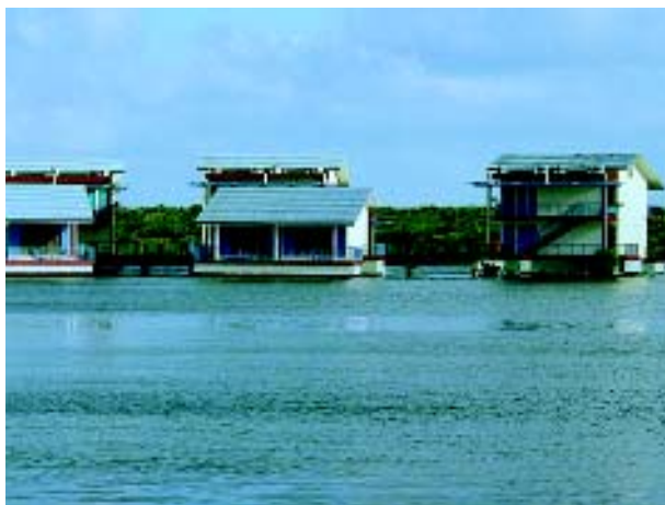
Fig. 11.5. La construcción de cabañas sobre pilotes evita tener que rellenar las lagunas en detrimento de la biodiversidad y el paisaje. Cabañas del Hotel Meliá Cayo Coco (Foto: James Dobbins).
