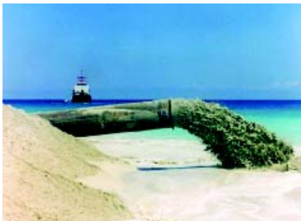
Fig. 9.2.1. La alimentación artificial de arena en la playa de Varadero ha mostrado altos niveles de retención de arena al cabo de varios años (Foto: Instituto de Oceanología).
