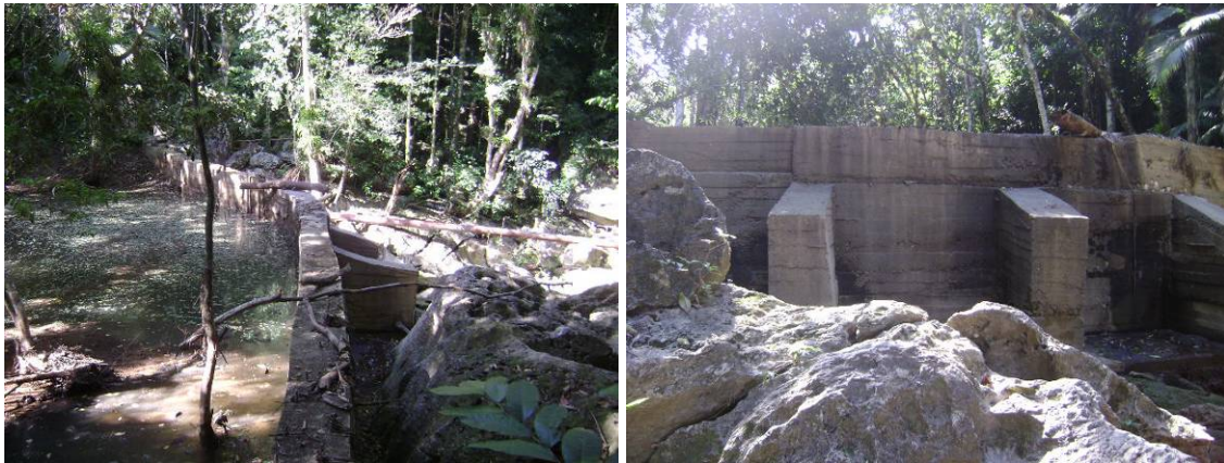
NUEVO TRANQUE CONSTRUIDO POR LA COMUNIDAD
