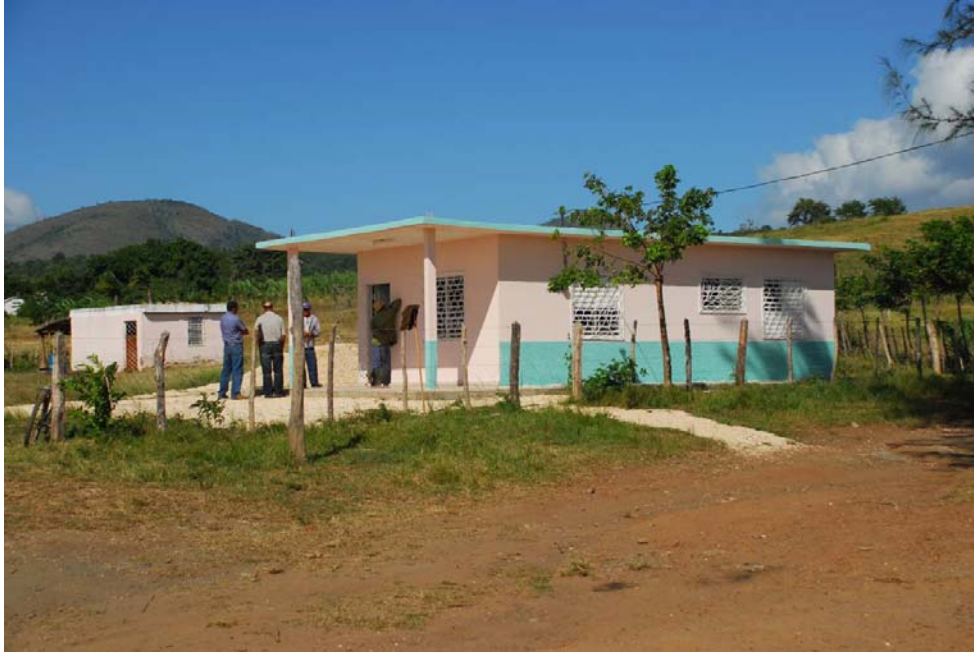
SEDE DE LA COOPERATIVA Y ÁREA DONDE SE DESARROLLARÁ LA MINI INDUSTRIA DE APROBARSE LA PROPUESTA DE PROYECTO FORMULADA.
