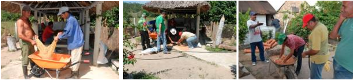
Fig. 12,13 y 14. Preparación de los materiales para la construcción.
