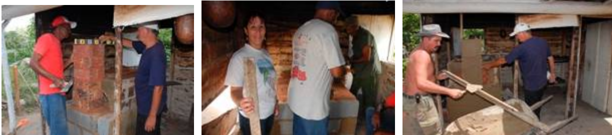
Fig. 15,16 y 17. Inicio de la construcción de la cocina eficiente.
