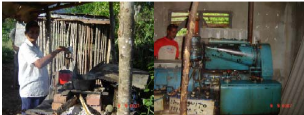
FOGÓN TÍPICO QUE UTILIZAN LAS FAMILIAS/PLANTA DIESEL QUE SERÁ DESACTIVADA CON LA ACCIÓN DEL PROYECTO.
