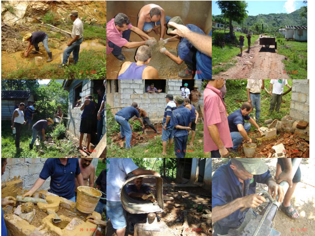
DIFERENTES MOMENTOS EN LA CONSTRUCCION DE LA COCINA
